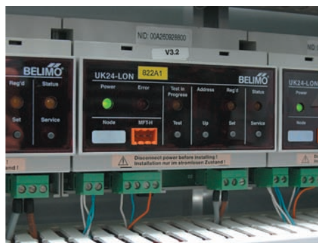
UK24LON-Geräte in der Lüftungszentrale, welche die Volumenstromregler mit MP-Bus und LON verbinden Quelle: BUS-House
